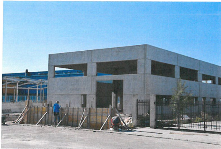
Radovi na hali tvrtke Capax d.o.o., Ražine
