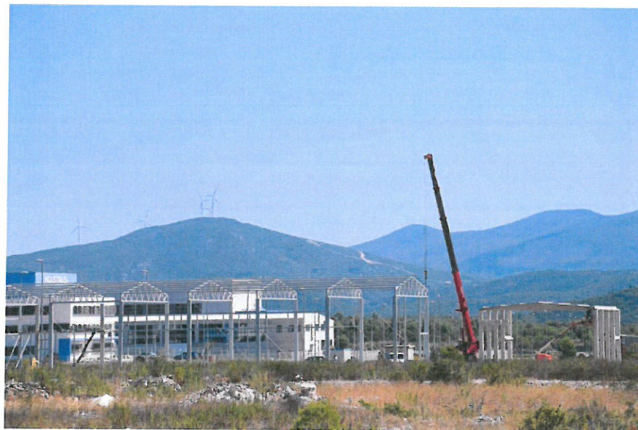
Početak gradnje hale Termes Podi d.o.o.
