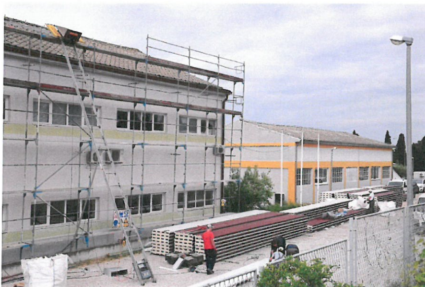
Radovi na rekonstrukciji krovništа, Poduzetnički inkubator PIN Šibenik
