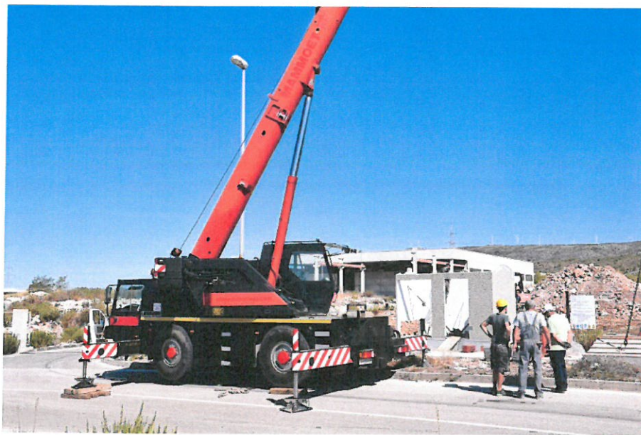
Postavljanje nove trafo stanice
